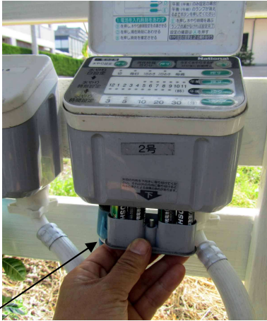
電池はタイマーの下側のネジを回して取り出します
