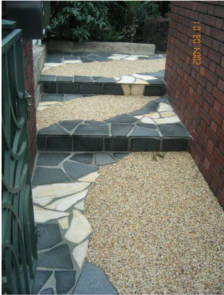
リンクストーンにピンコロ石と平板をデザイン
